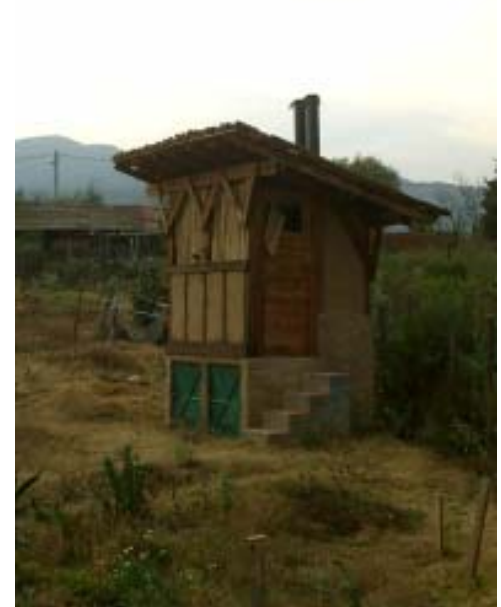
sanitario compostero de doble cámara en la Granja Tierramor, Erongaricuaro, Michoacán
