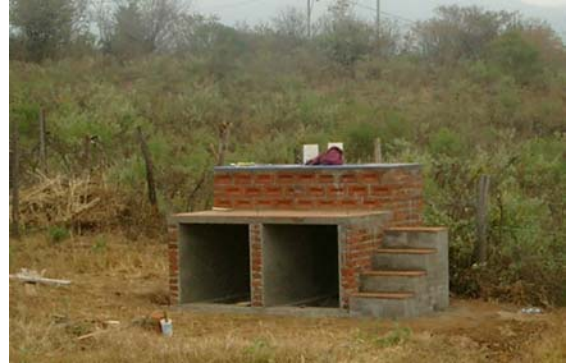
Base de un sanitario compostero, con el asiento integrado a la base
