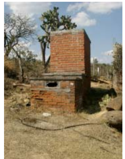
Triste ejemplo de un clivus multum mal construido (y nunca utilizado) durante una campaña masiva en el estado de Michoacán
