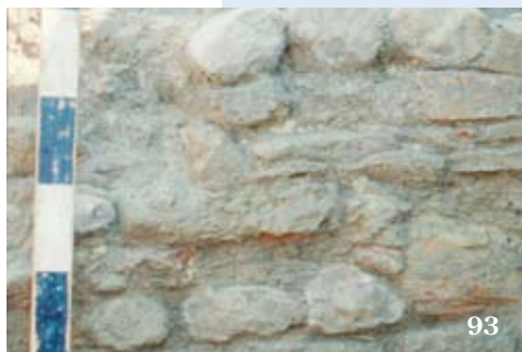
93. Scavi 1993, quartiere commerciale-insediativo: particolare di muratura riferibile alla ristrutturazione di età tardo-antica, nella c.d. opera listata, caratterizzata dal riutilizzo di materiali da costruzioni di età precedente (foto F. Nestore).
