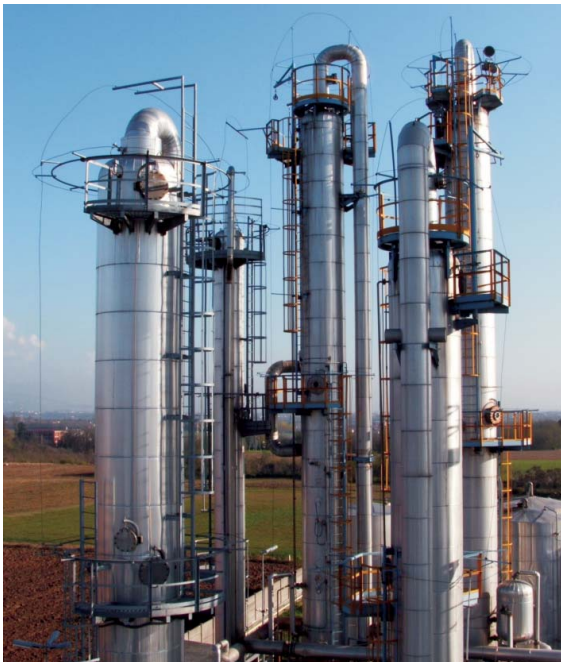
10.2 Destillationsturm einer Erdölraffinerie
