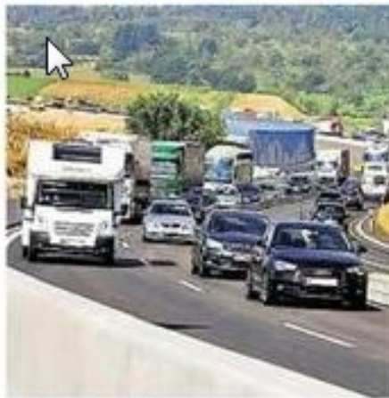
Fahrzeugkolonnen auf der neuen Brücke bei Nöttingen: Strahlt von der Höhe mehr Lärm in die Wohngebiete? Das befürchten die Anwohner in Nöttingen und Wilferdingen. FOTO: KETTERL
