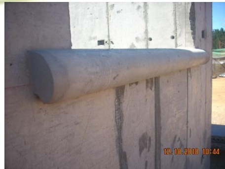
Foto 1- 2: moldaje de PVC confeccionado en obra con refuerzo interior de alambre de 4 mm y Alfeizar instalado con remate de terminación.
