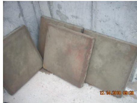
Foto 3 - 4: Confección de Pastelones con Hormigón H20 que sobra de la bomba de Hormigonado.
