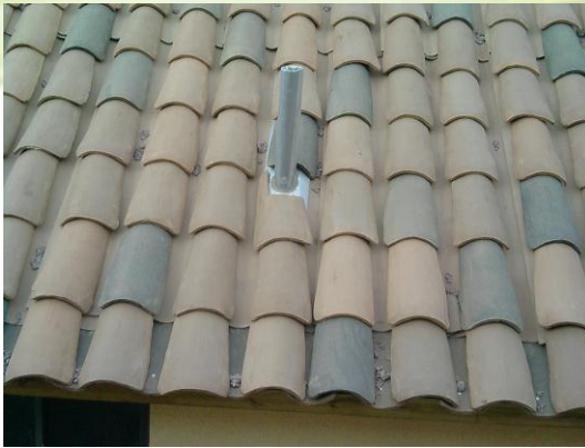
Foto1 - Arriba Izquierda – Teja mal instalada alrededor de Forro de Agua Lluvia [16].
