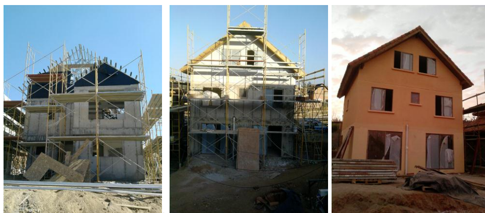
Foto 1 Arriba 1-2-3: Secuencia de revestimiento en casa Arce.
