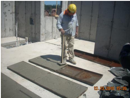
Foto 3 - 4: Confección de Pastelones con Hormigón H20 que sobra de la bomba de Hormigonado.
