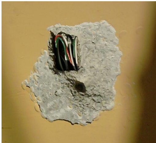
Foto5 Arriba Izquierda – Cañería de Eléctrica perforada por un fierro.
