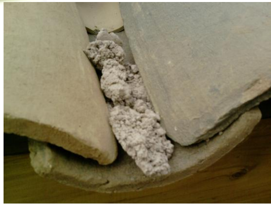
Foto1 - Arriba Izquierda – Teja mal instalada alrededor de Forro de Agua Lluvia [16].
