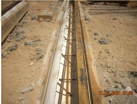
Foto 1- 2: moldaje de PVC confeccionado en obra con refuerzo interior de alambre de 4 mm y Alfeizar instalado con remate de terminación.
