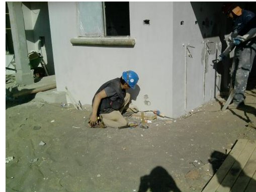
Foto5 Arriba Izquierda – Cañería de Eléctrica perforada por un fierro.
