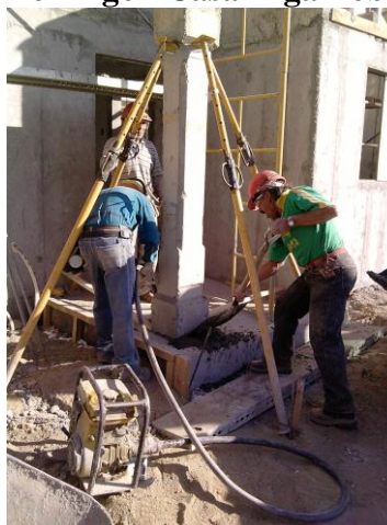
Foto 5-6: Proceso de instalación del pilar prefabricado de Hormigón en casa Algarrobo.
