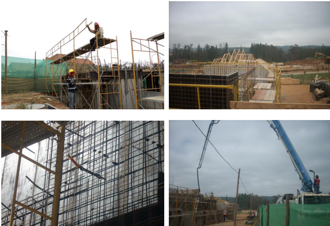
Foto1 Arriba - Izquierda: armando andamios en perímetro del 1° piso.
