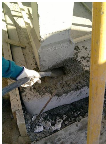
Foto 5-6: Proceso de instalación del pilar prefabricado de Hormigón en casa Algarrobo.
