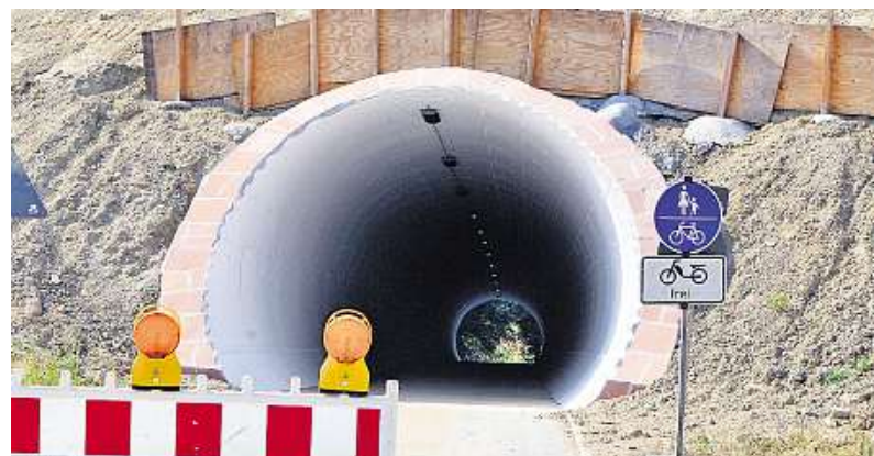
Provisorische Röhre bei Darmsbach: Eigentlich soll der Fuß- und Radweg nach dem Ausbau verschwinden – die Gemeinde könnte ihn aber erhalten, wenn sie nur will.
