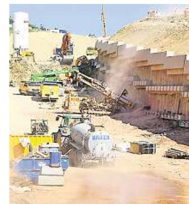
Im Endspurt: die fast 700 Meter langen Stützmauern bei Remchingen.
