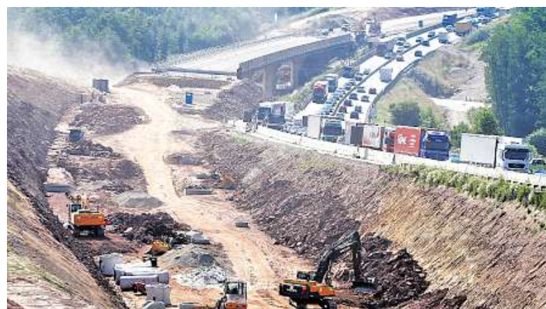
Eine Seite der Bocksachtalbrücke ist fertig, die neue Trasse entsteht gerade. Danach wird der Verkehr auf diese Fahrbahnen verlegt, um die alten Spuren umzugestalten.
