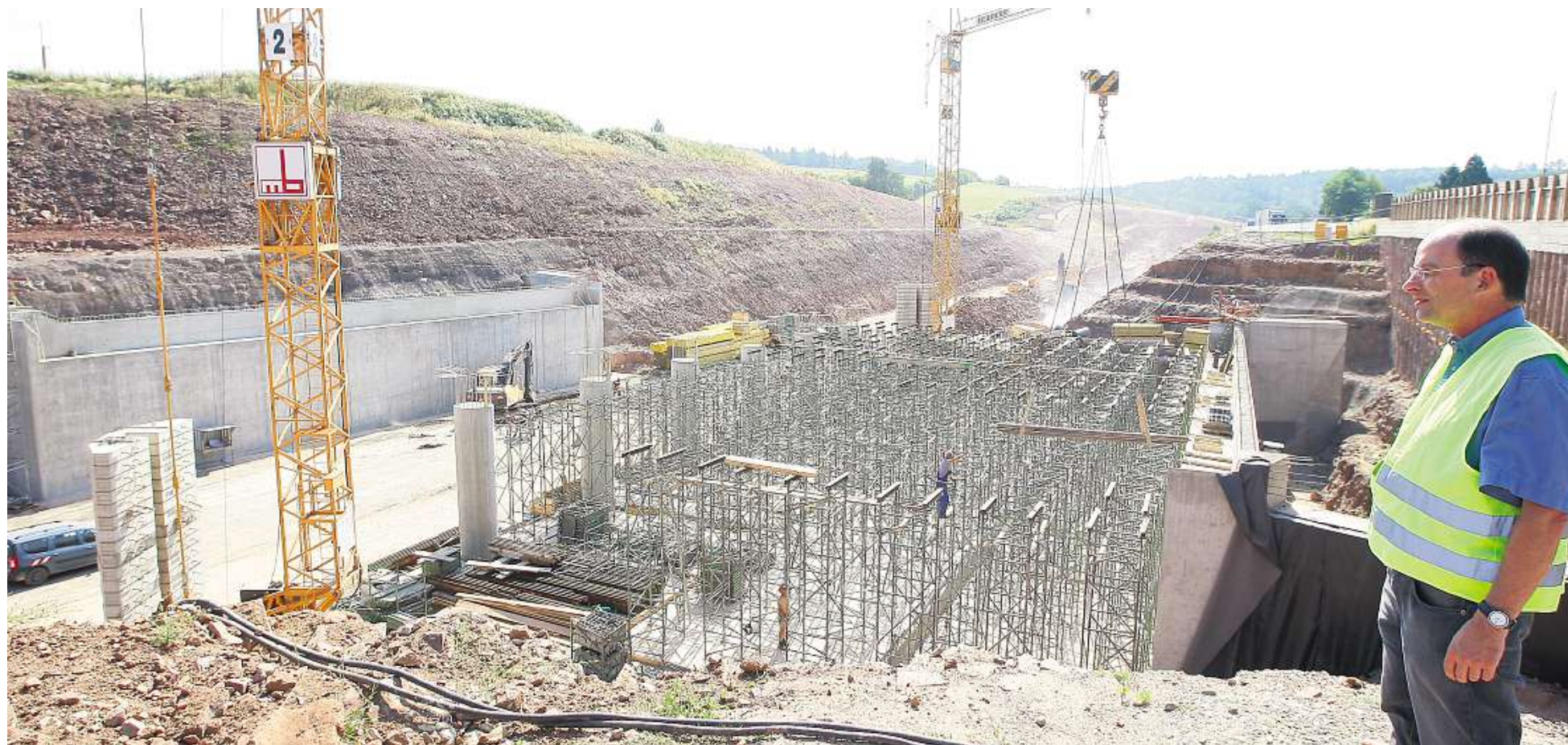
In großem Stil: Bei Mutschelbach wird die neue A8 besonders tief gebaut. Mit Gerüsten wird unter Regie des Projektleiters Ulrich Asal der Bau der künftigen Überführung vorbereitet.
