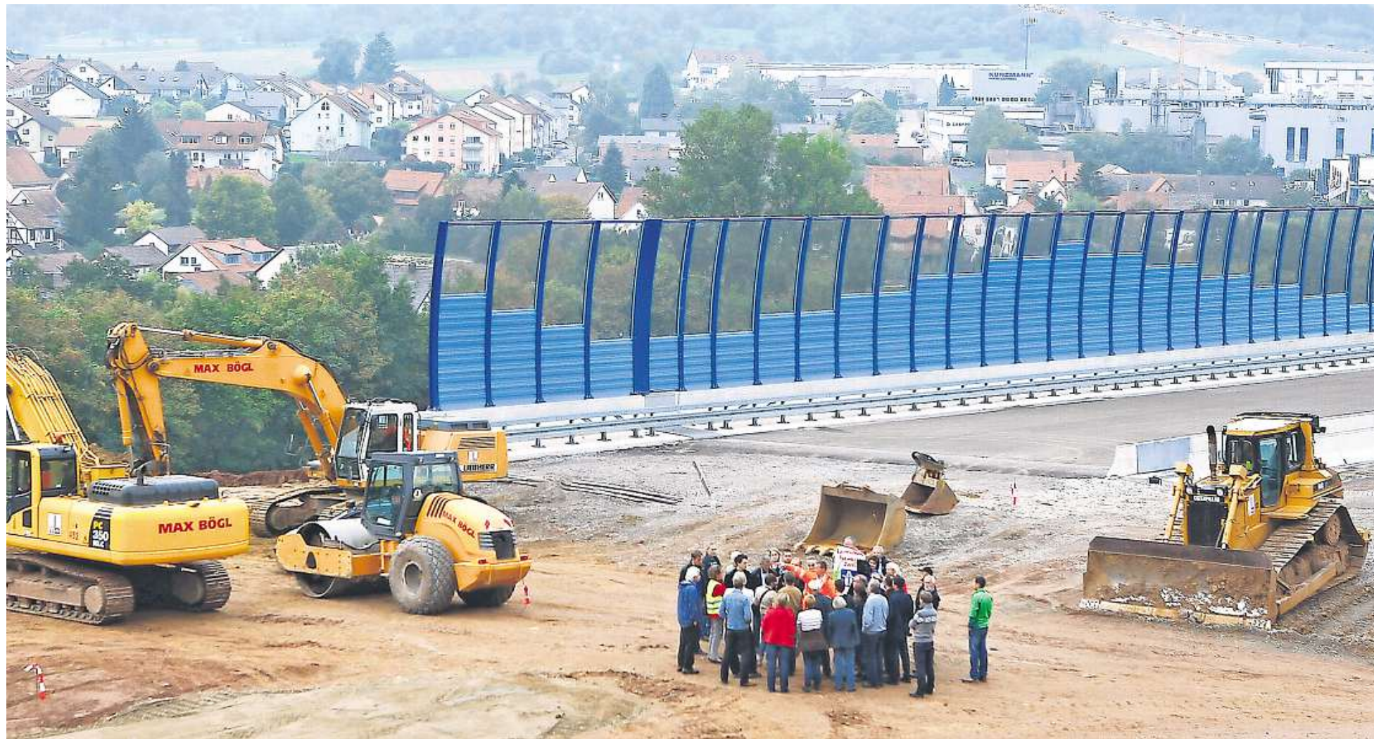
Wie viel Lärm strahlt von der neuen A 8 Richtung Nöttingen? Anwohner schauen sich die Situation auf der fertigen Pfnitztalbrücke und der Trasse, die zurzeit gebaut wird, ganz genau an.
