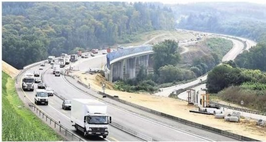
Berg- und Talfahrt ade: Die rund 25 Meter hohe und etwa 480 Meter lange Pfinztalbrücke überspannt nun das Nöttinger Tal.
