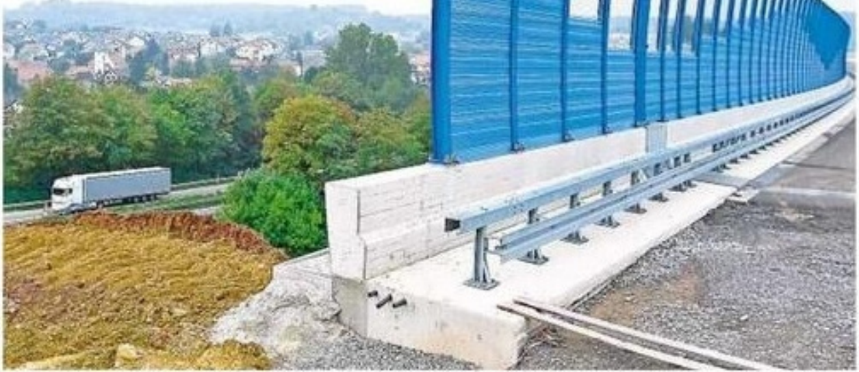
Reicht die Wand auf der neuen Pfinztalbrücke, den Lärm von Nöttingen fernzuhalten? Gemeinde und Bürgerinitiative wollen mehr, doch das Bundesverkehrsministerium erklärte nun, das koste zu viel Geld. FOTO: KETTERL, ARCHIV
