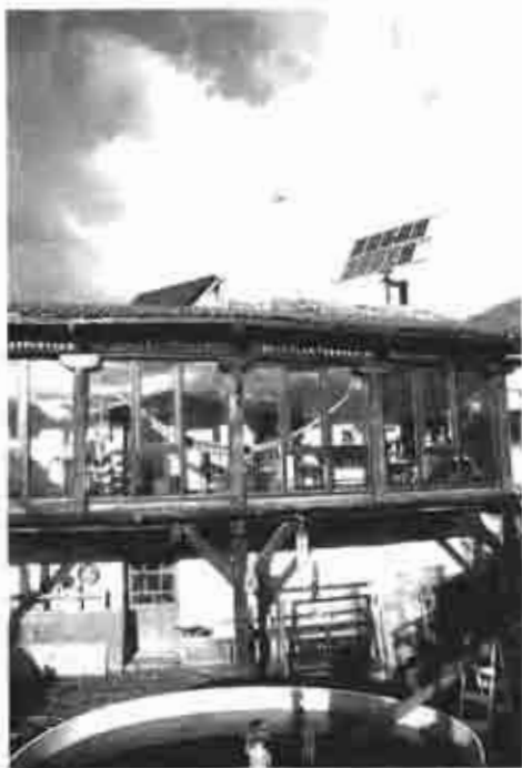
La rehabilitación ecológica es uno de los mejores exponentes del ahorro de energía. A esta casa se le añadió el invernadero, se mejoró el aislamiento y se le dotó de sistemas para aprovechar el sol y el viento. El agua de lluvia se emplea para regar.
