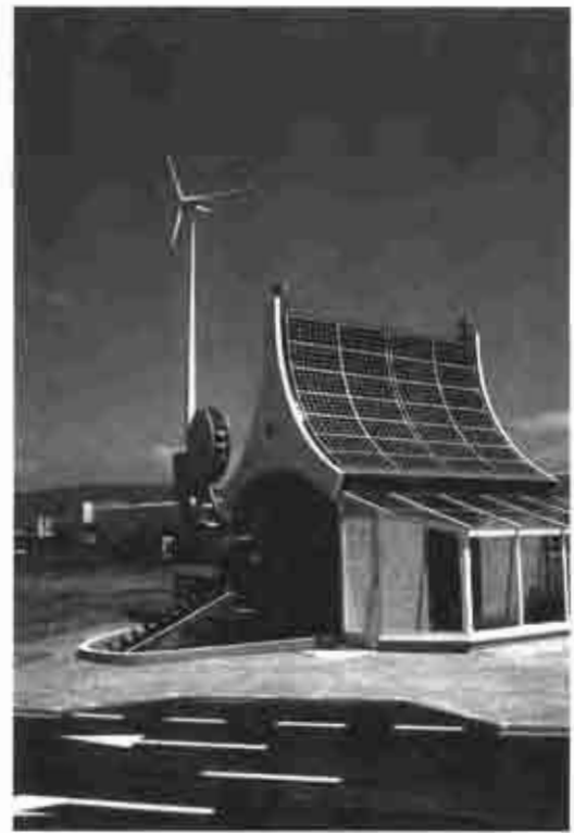
En esta pequeña casa para que los niños se familiaricen con las energías renovables, se han integrado sistemas hidráulicos, eólicos y solares. Ha sido hecha por la empresa Energía Hidráulicas de Navarra en el Parque Infantil de Tráfico Polo, de la Fundación Volkswagen Navarra - CAN (Polígono Landaben de Pamplona).
