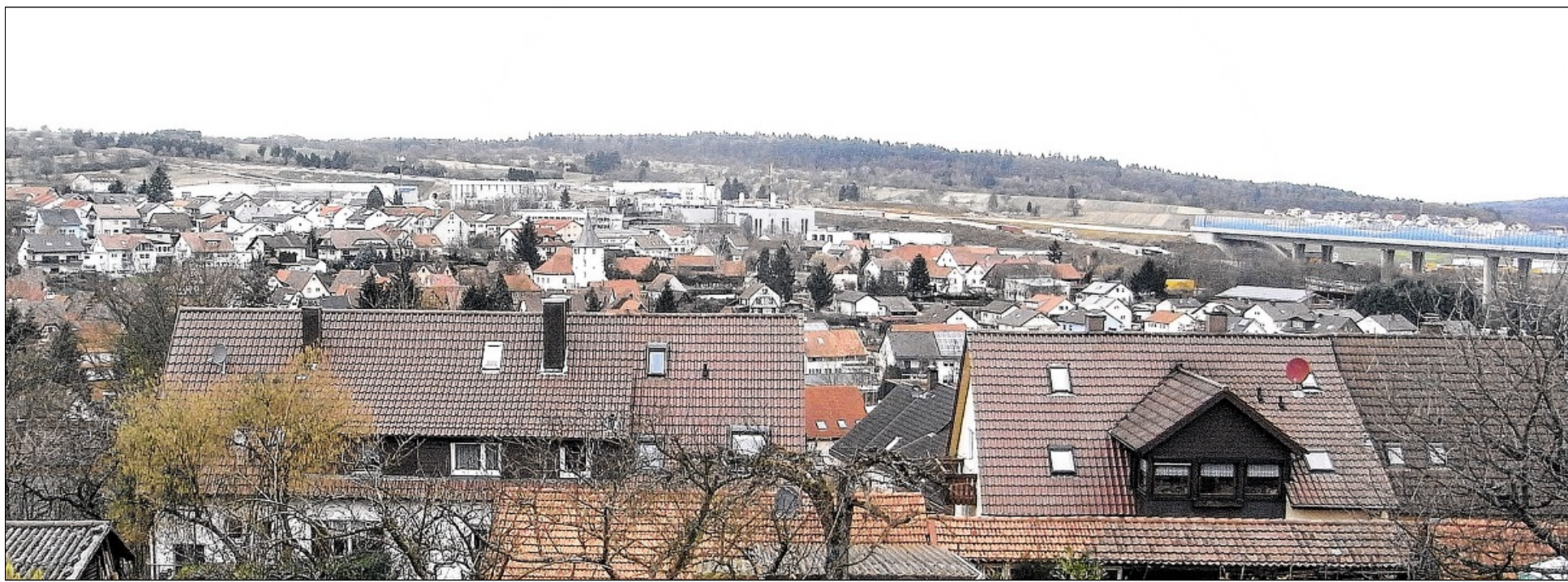
FÜR UNZUREICHEND hält die Remchinger Bürgerinitiative „Ruhe Jetzt“ den Lärmschutz an der Autobahn für Nöttingen und Darmbach, zumal bekannt wurde, dass die Planfeststellung auf falschen Zahlen basiert. Trotzdem hat der Bund die Verwendung eines lärmindernden Asphalts abgelehnt. Dagegen wendet sich nun die Initiative. Foto: PK
