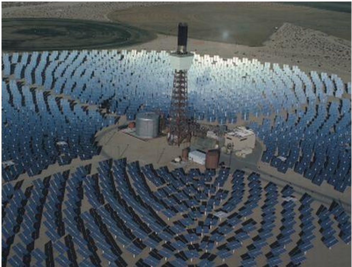
Figura 22. Central de Generación Termo Solar de Torre
