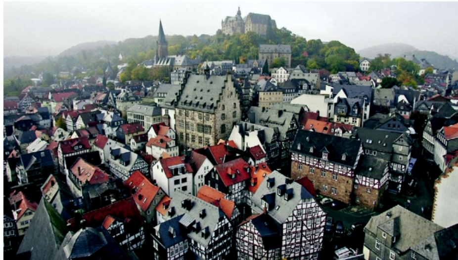
Auch viele Dächer der Marburger Oberstadt eignen sich für eine Photovoltaikanlage.
